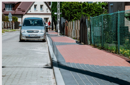
Budowa części chodnika przy ul. Ogrodowej we Władysławowie
