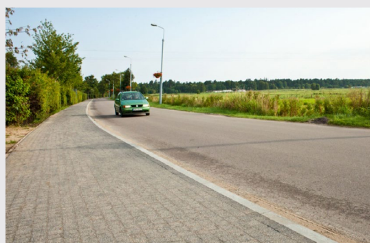
Remont istniejącego chodnika przy ul. Plażowej w Ostrowie (94 mb x 1,5 m)
