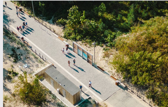
Budowa wejść na plażę nr 1-7, 9 we Władysławowie
