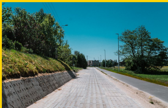
Ułożenie płyt yomb na odc. ul. Karwieńskiej i Krokowskiej w Ostrowie
