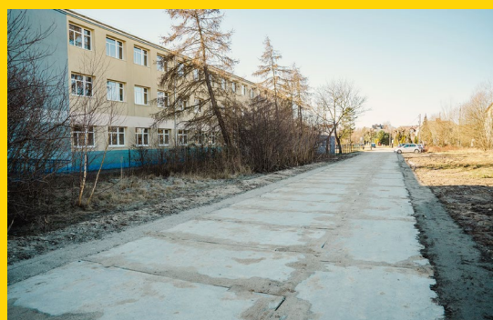
Budowa łącznika ul. 1000-lecia P.P. i ul. Ratowników Morskich we Władysławowie
