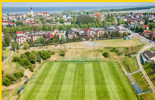
Wymiana częściowego ogrodzenia boiska piłkarskiego przy ul. Zwirowej we Władysławowie
