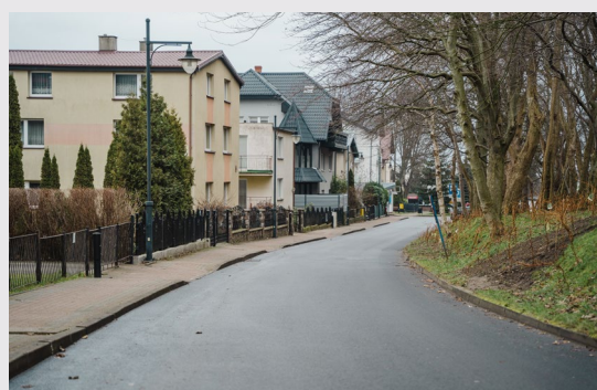
Remont nawierzchni bitumicznej ul. Parkowej we Władysławowie
