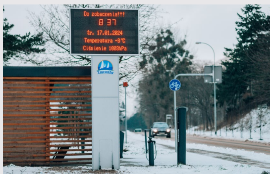
Montaż stacji meteorologicznej w Tupadłach
