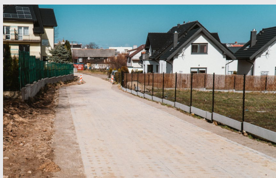
Budowa łącznika między ul. Męczenników Wielkiej Wsi a ul. Średnią we Władysławowie z płyt yomb
